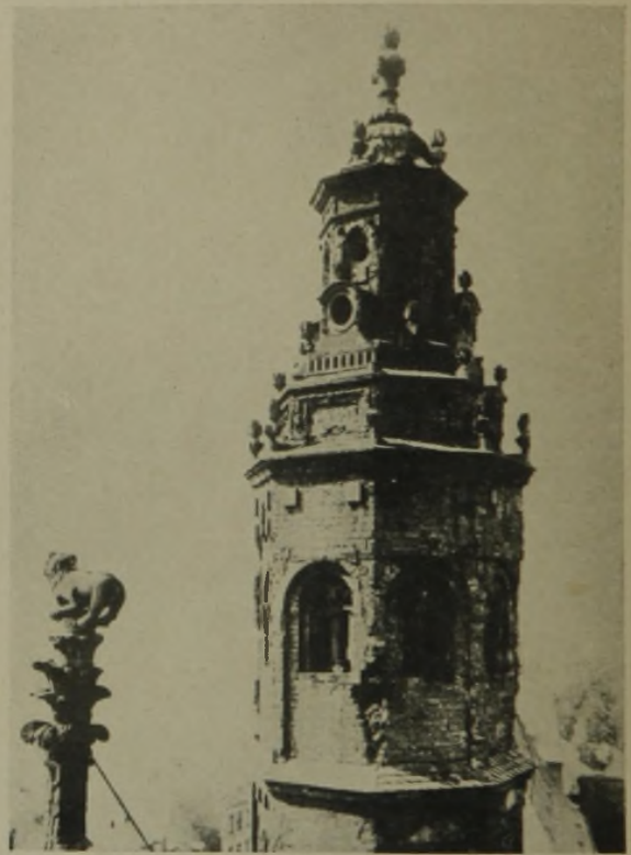
Abb. 3. Äußere Zerstörungen an einem Flankenturm der Westgruppe.
