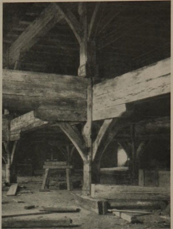
Abb. 7. Stützen im I. u. II. Obergeschoß.
