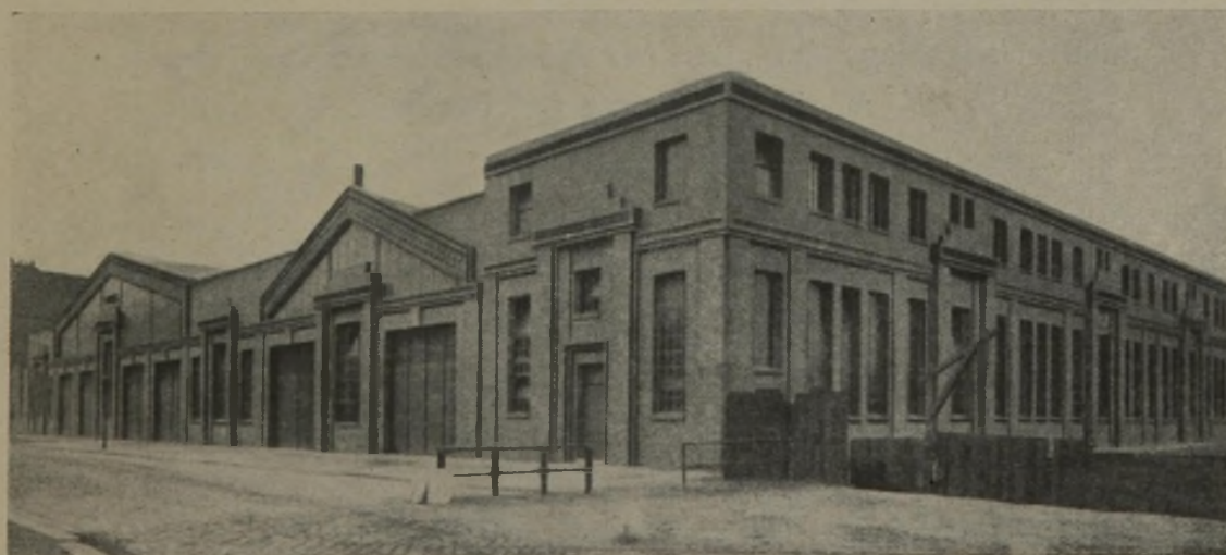
Abb. 2. Ansicht der Garage von der Morsestraße.
