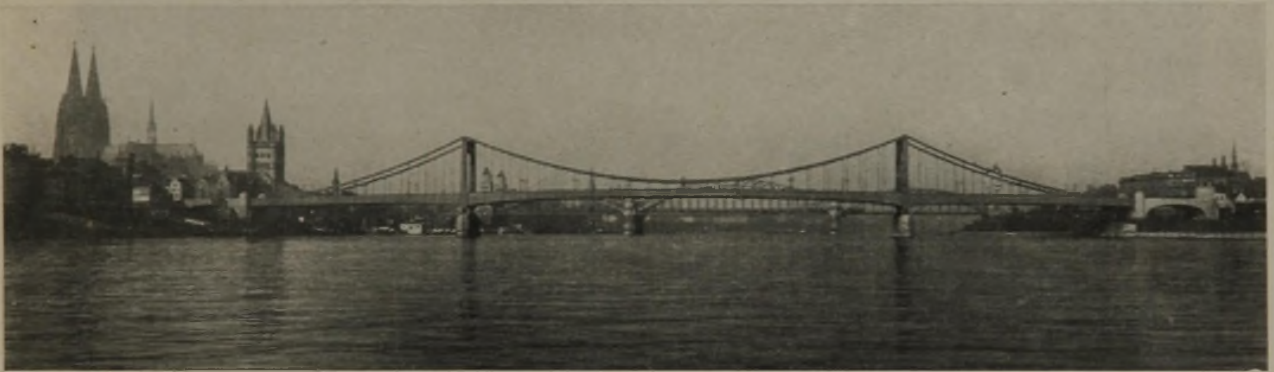
Abb. 10. Straßenbrücke über den Rhein in Köln. (M. A. N. u. Arch. Baurat Moritz, Köln)
