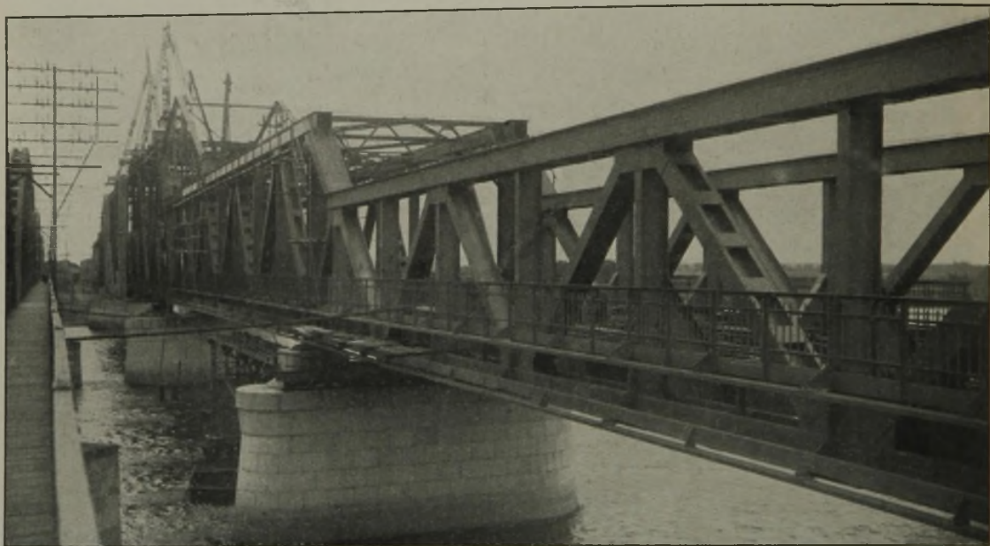
Abb. 13. Eisenbahnbrücke über die Elbe bei Hämerten.
