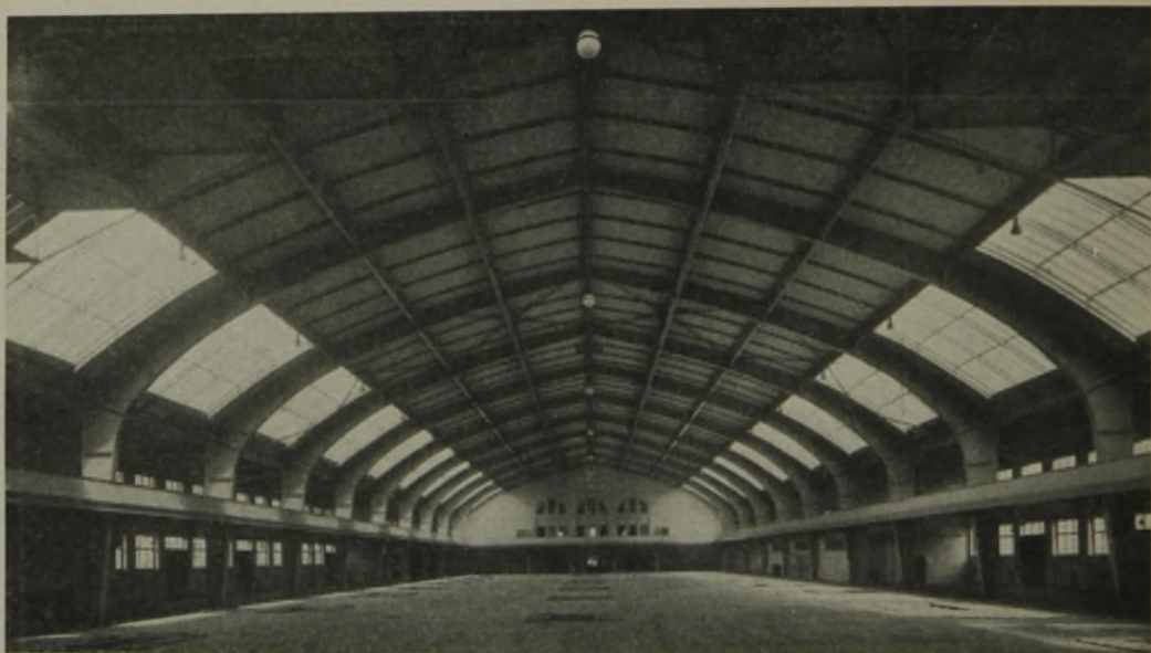
Abb. 7. Ausstellungshalle II am Kaiserdamm in Berlin. Arch. Emil Schaudt und Jean Krämer mit Breest & Co.
