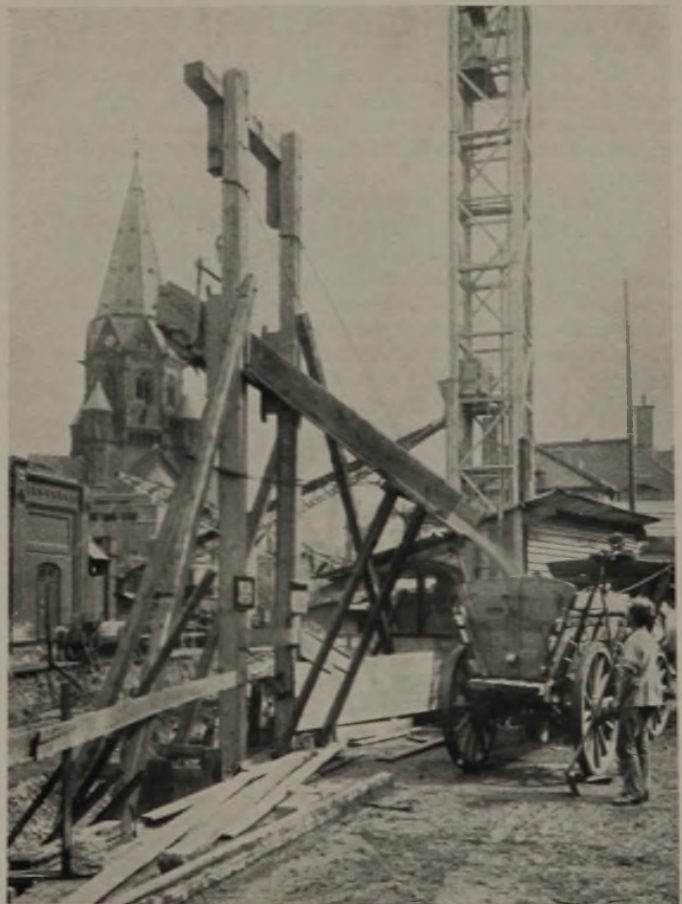
Abb. 13. Deubag-Lasten-Aufzug.
