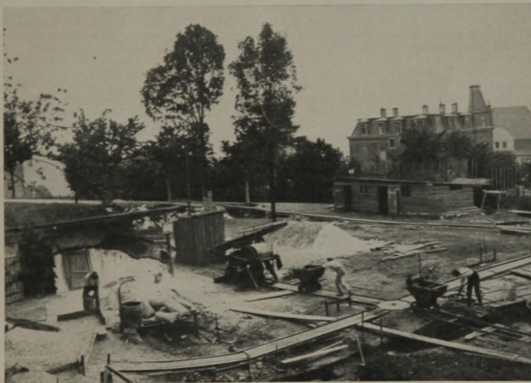
Abb. 1. Baustelle mit Gleiswegen für den „Saxonia“-Beton- und Mörtelmischer. (Deutsche Baumaschinen-Gesellschaft Rammer & Co. Mügeln, Bez. Leipzig.)
