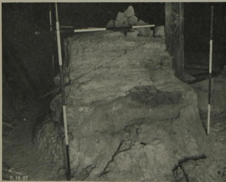
Abb. 9. Verfestigter Körper nach Entfernung der Bohlwand und Abspritzen mit Wasser.
