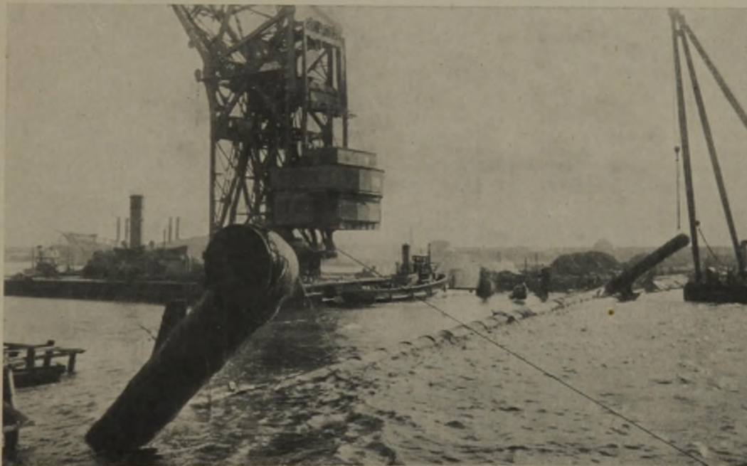
VERSENKUNG DES DÜKERS MIT DREH- UND HILFSKRAN
