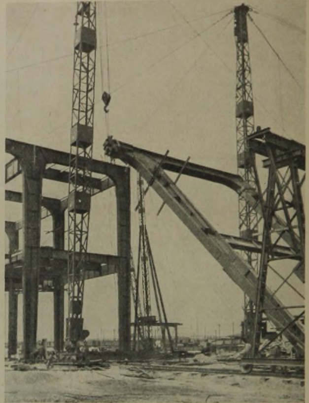
RAHMENKONSTR. KOHLENMAHLANLAGE. ABB. 8
