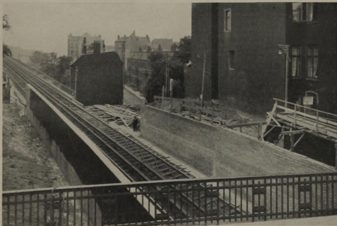
BLICK AUF DIE BAUSTELLE MIT DEN NEUEN STÜTZMAUERN Sämtl. Aufnahmen von Phot. Gebr. Dransfeld, Hamburg
