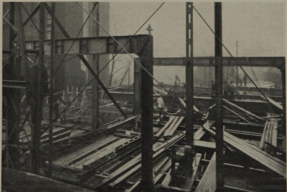
ABB. 27. EISENGERÜST DES HOCHBAUS
