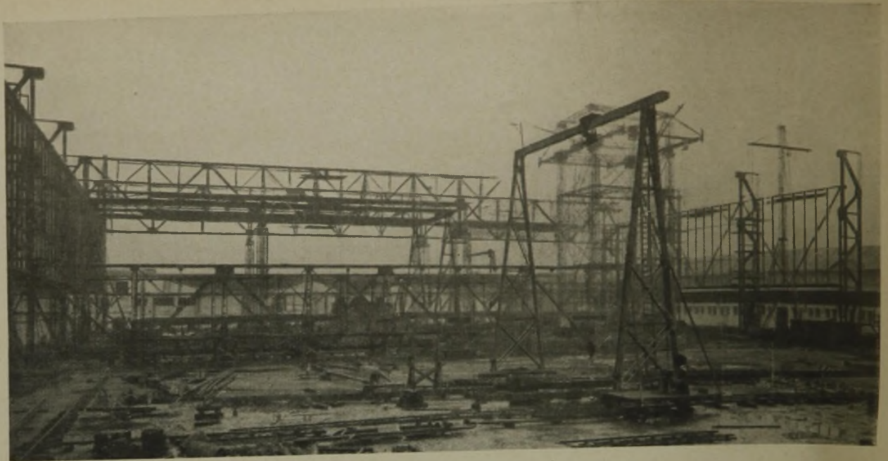
BILD DER MONTAGE. TEIL DER STÄNDER AUFGESTELLT. ERSTE BINDER IN AUFSTELLUNG
