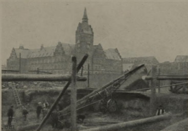
ABB. 19 (UNTEN) HEINZELMANN- AUFLADER Mit doppelt schwenk- barem Transportband auf Raupenband ver- fahrbar Heinzelmann & Sparmberg, Hannover
