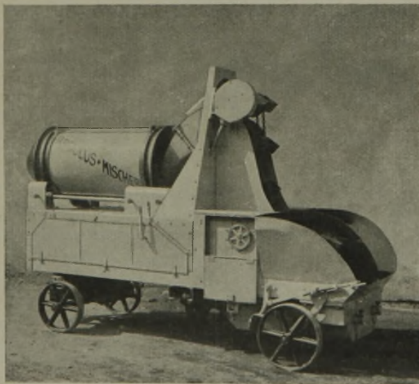
ABB. 5. BETON-MISCHAUTOMAT „REGULUS“ D. R. P. mit teilweise freigelegtem Becherwerk G. Anton Seelemann & Söhne, Neustadt, Orla Neuere Typen von Beton-Mischmaschinen
