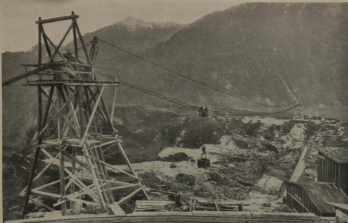
KABELKRAN BEIM BAU DER TAUERNMOOS-TALSPERRE Adolf Bleichert & Co., A. G. Leipzig
