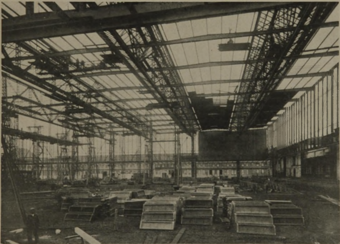
FORTGESCHRITTENES STADIUM DER MONTAGE RECHTS FERTIGE KONSTRUKTION, LINKS UNTEN BINDERMONTAGE
