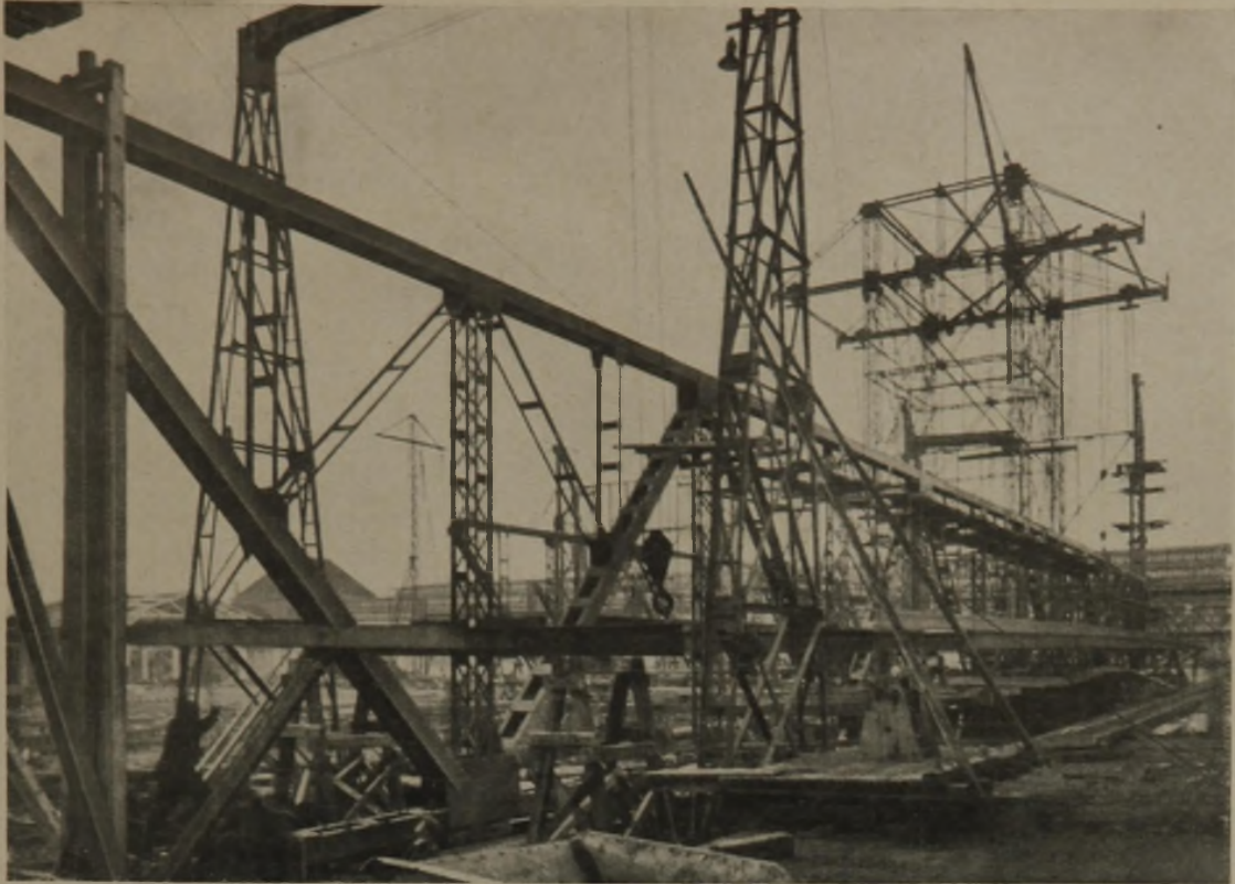
VORN BINDER BEI DER ZUSAMMENSETZUNG AM BODEN. RECHTS AUFZUGSGERÜST
