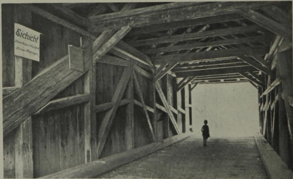
BRÜCKE ÜBER DIE LOQUITZ IN EICHICHT, LANDKREIS SAALFELD. Erbaut 1836 Eine Spannung von rd. 20 m, lichte Breite 4,55 m, lichte Höhe 3,75 m. Schieferdach
