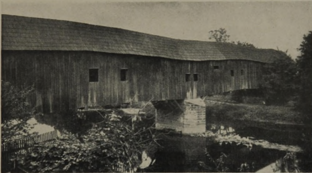
GEDECKTE ELSTERBRÜCKE ZWISCHEN WÜNSCHENDORF UND VEITSBERG, LANDKREIS GERA. Erbaut 1876 Länge 70 m, lichte Breite 4,70 m, lichte Höhe 3,4 m. Schindeldach Phot. Dr.-Ing. Boese, Weimar
