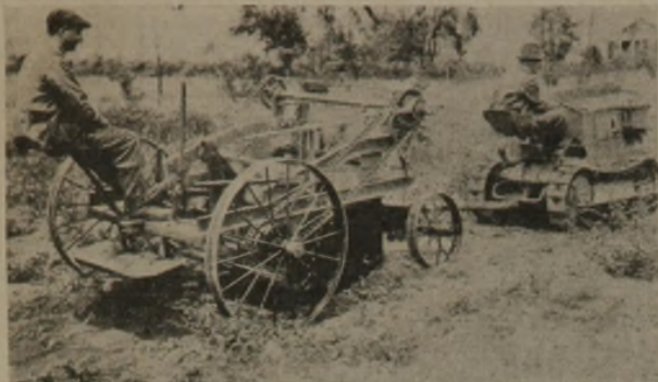
ABB. 7. SCRAPER BEI HERSTELLUNG DES STRASSEN- PLANUMS FÜR BETONSTRASSEN
