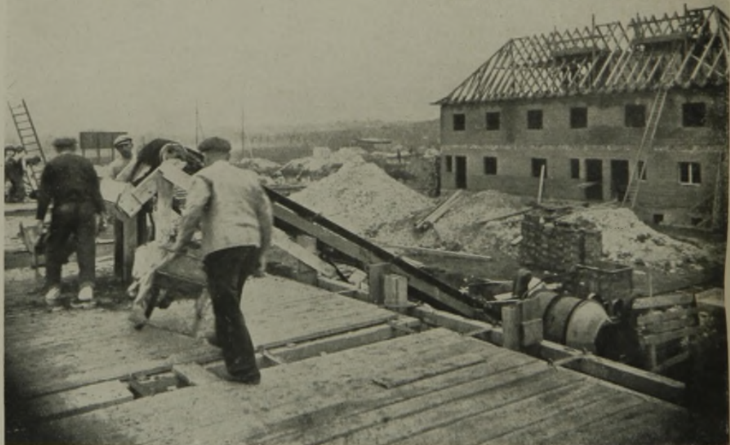
Karrenschieber auf dem Schüttbodyen des Erdgeschosses, das vom Gurtförderer oben abgeworfene Mischgut auffangend
