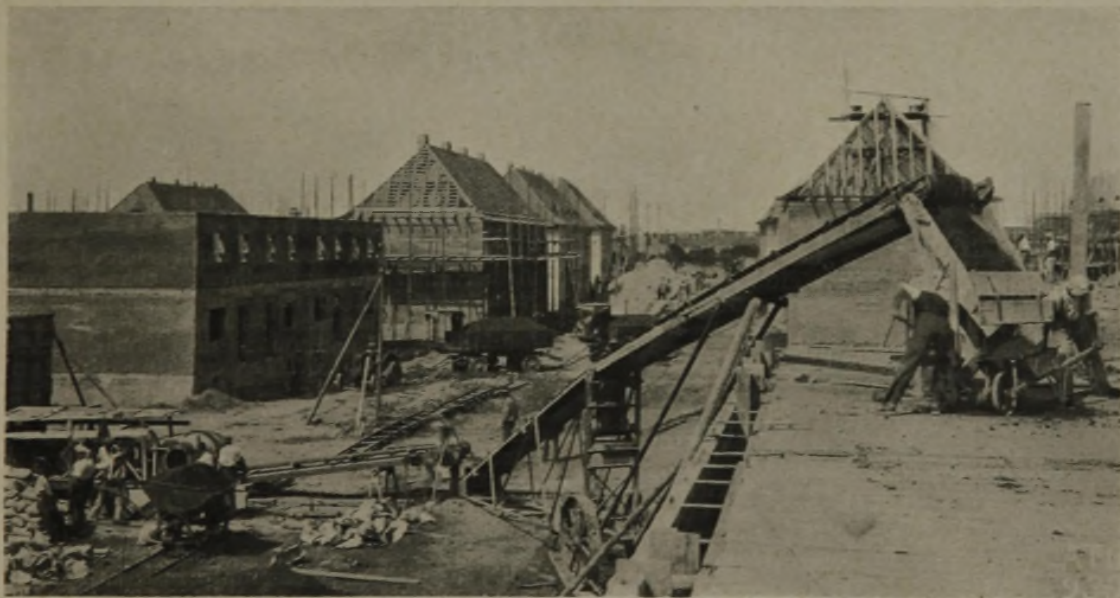
Kombination: Feldbahn — Betonmischmaschine — 10 m Zwischenförderer — ATG — 20 m Gurtförderer — Schütthoden — Schalungsform für Erdgeschoß
