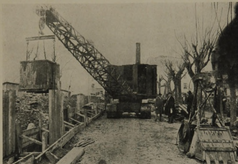
ABB. 4. DAMPFBAGGER MIT KASTEN MIT BODEN- KLAPPE BEI KANALISATIONSARBEITEN
