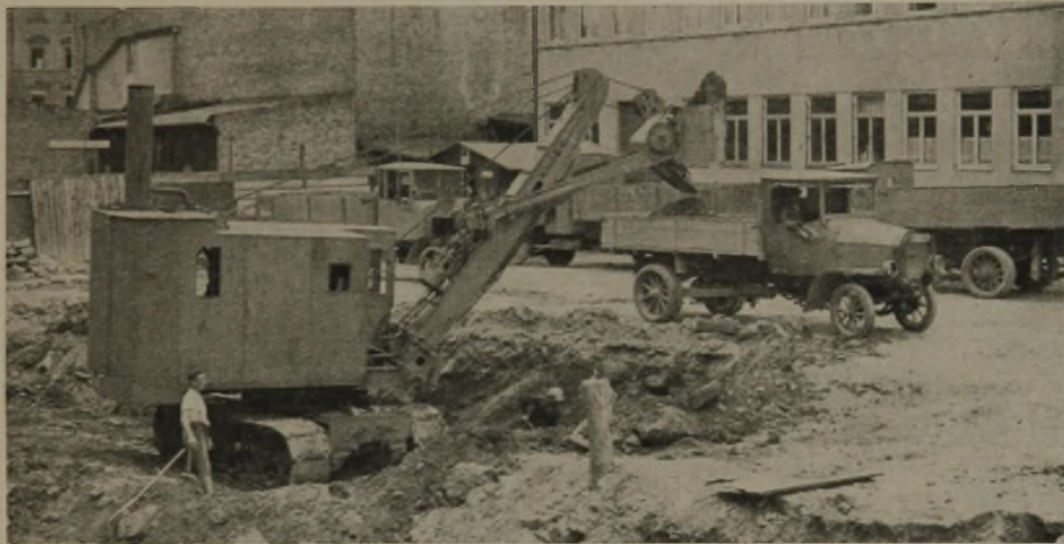
DAMPF-LÖFFELBAGGER BEIM AUSHUB EINER FUNDAMENT-BAUGRUBE
