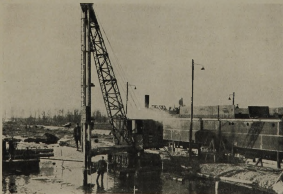
ABB. 5 DAMPFBAGGER MIT RAMM-EINRICHTUNG
