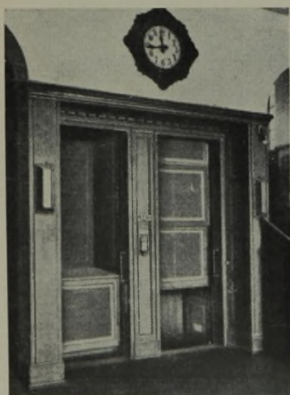
ABB. 7. PATERNOSTER-AUFZUG IM VERWALTUNGSGEBÄUDE DER A T G (ALLG. TRANSPORTANLAGEN-GES. LEIPZIG)
