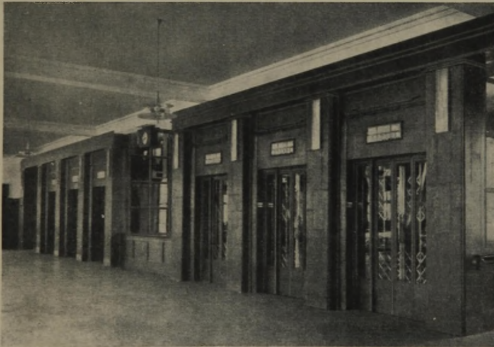
PERSONEN-AUFZÜGE IM WARENHAUS R. KARSTADT A.-G., HAMBURG-BARMBECK Tragfähigkeit 900 kg = 12 Personen. Geschwindigkeit 1,5 m Sek. Ausführung Carl Flohr A. G., Berlin
