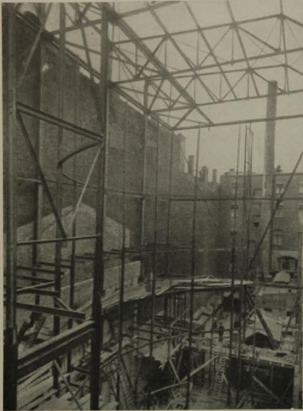
MONTAGE DER KONSTRUKTION DES BÜHNENHAUSES
