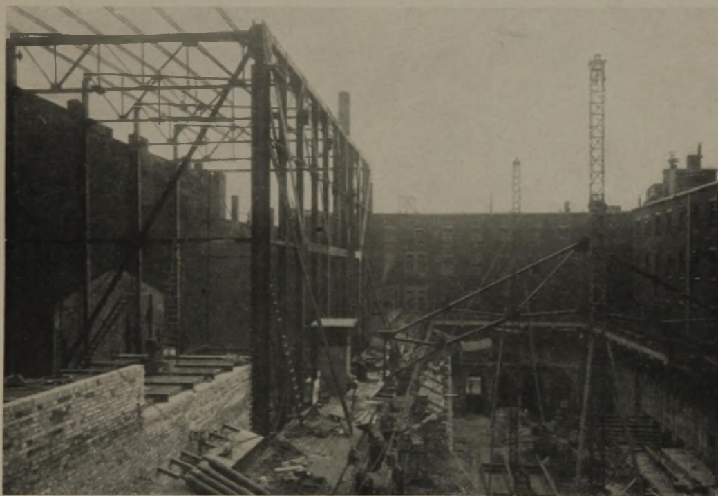
AUFSTELLUNG DER NEUEN STAHLKONSTRUKTION
