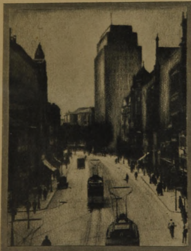
Abb. 15. Schaubild. Ein Ankauf. Kennwort: „Achse der Königstraße“. Verf. Arch. Willy Schönfeld, Chemnitz. Wettbewerb für einen Hotelbau in Chemnitz.
