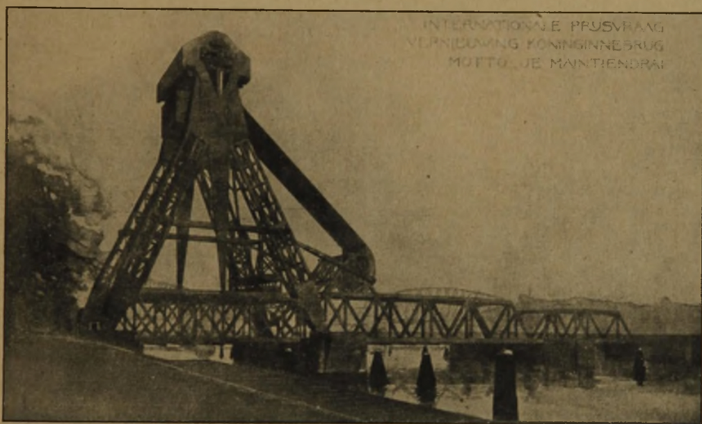
Abb. 6 (oben). Brücke mit klappbarem Dreigelenkbogen (mit betontem Bewegungsmotiv).
