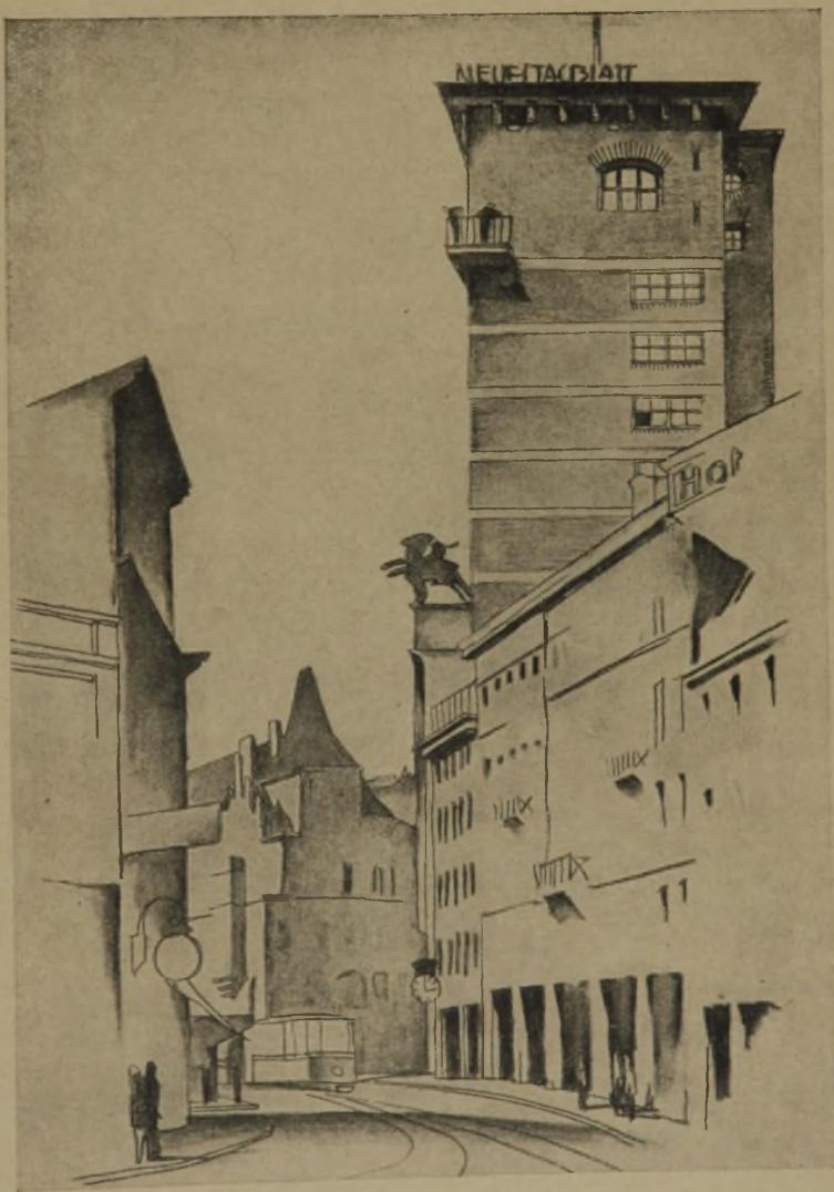
Abb. 8. Gesamtbild im Zuge der Ebertstraße mit Blick gegen die Ecke Eberhard- und Torstraße.
