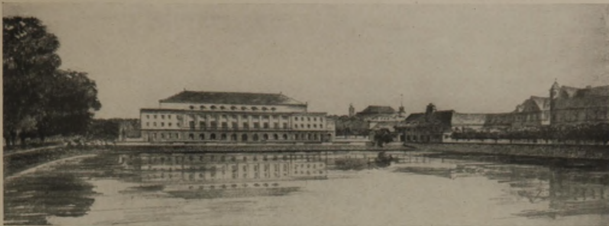
Abb. 6. Blick auf die Stadthalle auf dem Platz „Möllingsruh“.
