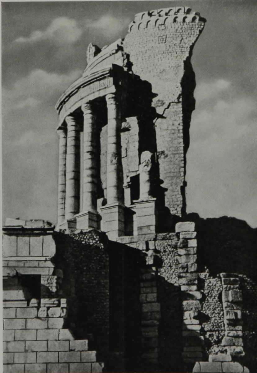
Wachturm für große Baurechnung zu Ehren des Kaisers Augustus. Edler weißer Marmor, durch Steinraub zerstört. Die große hellenistische Säulenrotunde war mit dem Baukörper oben konstruktiv verbunden. — Peinlich sortiertes Füllmaterial.
