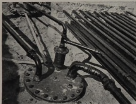
Mannloch oder Einsteigeschacht für Füllung, Entlüftung, Absaugrohr und Blitzschutz (meist Bänder) links: Saugrohr (führt zur Zapfstelle), Mitte: Lüftungstopf, rechts: Füllrohr für den Tank.
