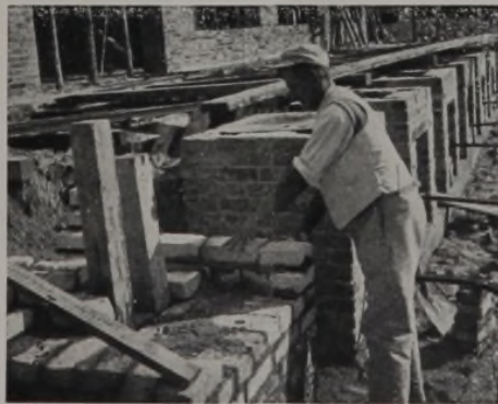
Arbeit an einem der vier Stützpfeiler, auf denen die Ueberdachung der ganzen Tankstelle ruhen wird.
