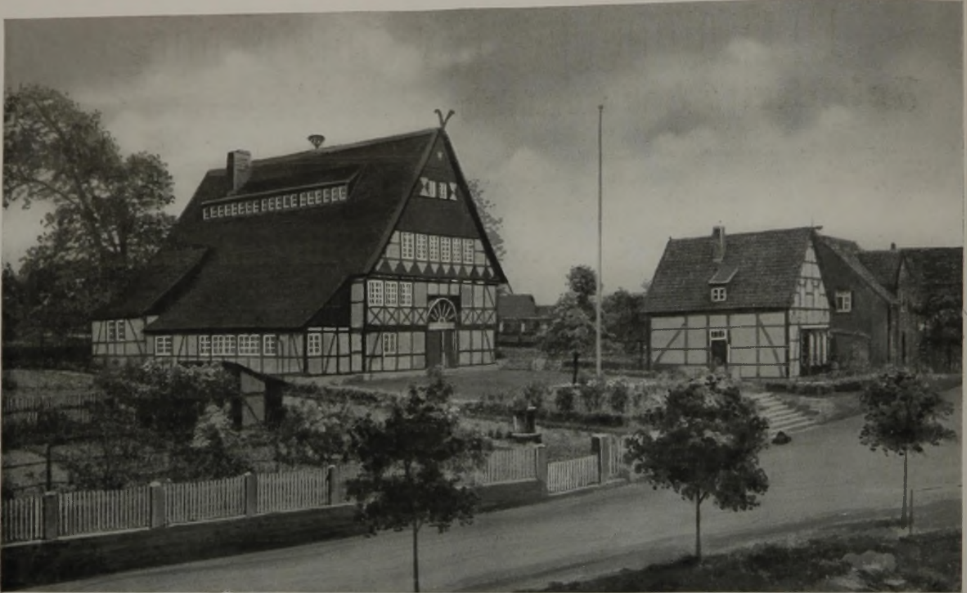
Gemeinschaftshaus in Wevelsburg i. Westf.
