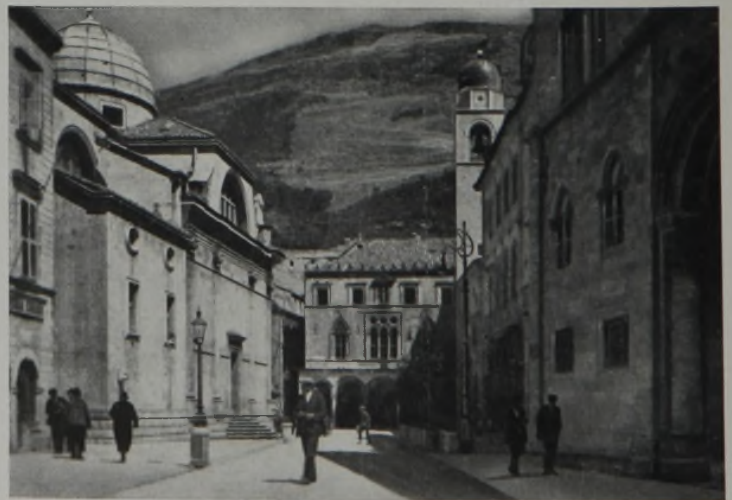
Wändeausbildung nach dem Wiederaufbau.
