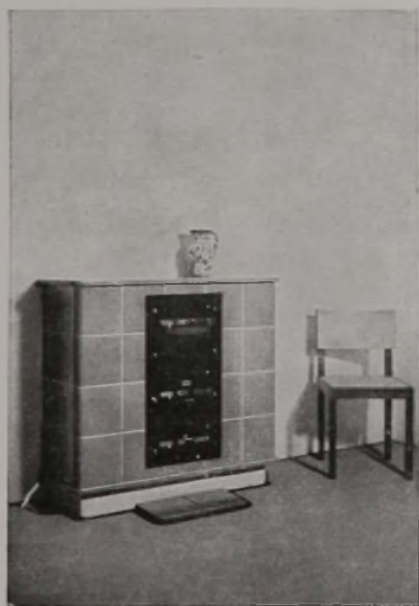
Abb. 3. Wohnzimmerseite eines Summa-Kachelofens, gleichzeitig Feuerungsstelle.
