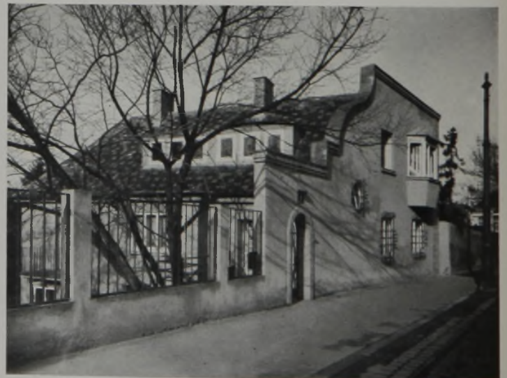
Bild 1. Diagonal-Ansicht im Blickpunkt von der hochgelegenen Wollergasse aus mit geschickter Verkleidung der unregelmäßigen Dachform (Schräg- und Flachdach) durch die in geschwungenen Linien zur Einfriedigung überleitende Ansicht. Auch hier fehlt der Spritzsockel in wasserdichtem Hartputz; der Putz löst sich unten bereits auf. Putz und Abwässerung der Einfriedigung zeigen ebenfalls Netzrisse als Beginn des Verfalls. Der sonst feingliedrige Ausbau ist im unteren massiven Teil etwas mißlungene Formung.
