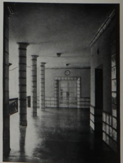
Vorplatz an der Haupttreppe, Fliesen weiß mit grünen Streifen, Wand graugrün, Linoleum grau und grün kariert (Fliesenlinoleum).
