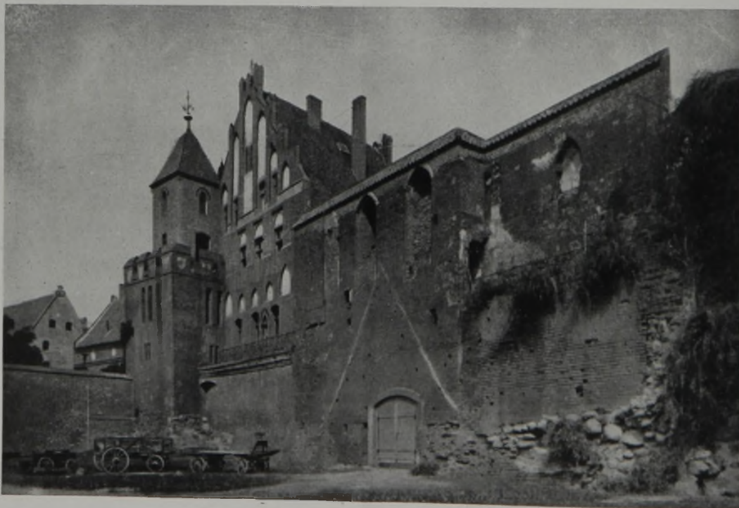
Ordensbau Junkernhof in Thorn.
