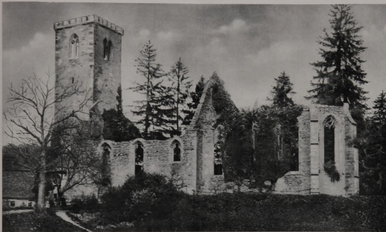
Die Kirchenruine in Truttenhausen i. E. mit dem Wacht- und Glockenturm.
