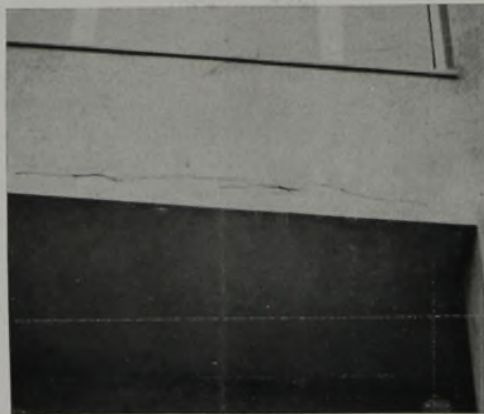
Abb. 2. Die gleiche Erscheinung und Frosteinwirkung über der äußeren Türöffnung an der Wetterseite. Hier beginnt der glatte Putz bereits abzublättern. Haarrisse über dem Sturz setzen mit Frost das Zerstörungswerk fort.
