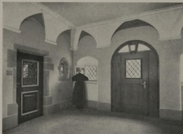
Die Behandlung der Räume geschah mit großer technischer Sorgfalt. Die Stichbogenkappen sehen in der Wirklichkeit besser aus als im Bilde.
