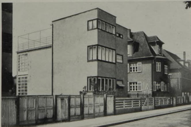
Abb. 1. Sichtbare Flächenfeuchte. Falsch konstruierte Mauerabdeckung. Flachdach als Vermittler für innere Wasserversorgung. Vorn und hinten Licht und dazwischen schattenlose Fläche. Markthürden kennzeichnen den Außenseiter dieser Leipziger Häuser!
