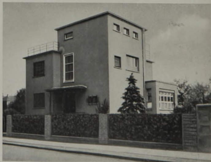
Abb. 3. Form, Gliederung und Flachdach eigenwillig orientalisches. Pflanzung und Einfriedigung nähert sich betont exotischem Zwittergefühl. Tränende Profile an den Sohlbänken. Feuchtsalzige Rinnen- und Dachanschlüsse, Einfriedigungspfeiler als Rohköstler gegenüber dem putzgesättigten Gebäude als Wirtschaftsunikum exotischer Gedankengänge.
