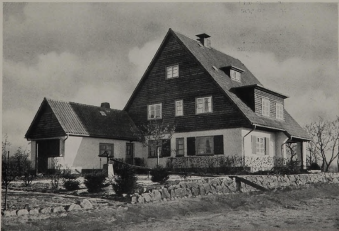
Ueber der hellen Putzfläche mit den dunkelgrünen Fensterläden bestimmt der massige breite Giebel mit brauner Stülpschalung den Hauptcharakter des Hauses als wettergeschütztes Heim. Bei einem Rauminhalt von 914 cbm zu je 19,80 RM. kostete das Haus 17 366 RM.
