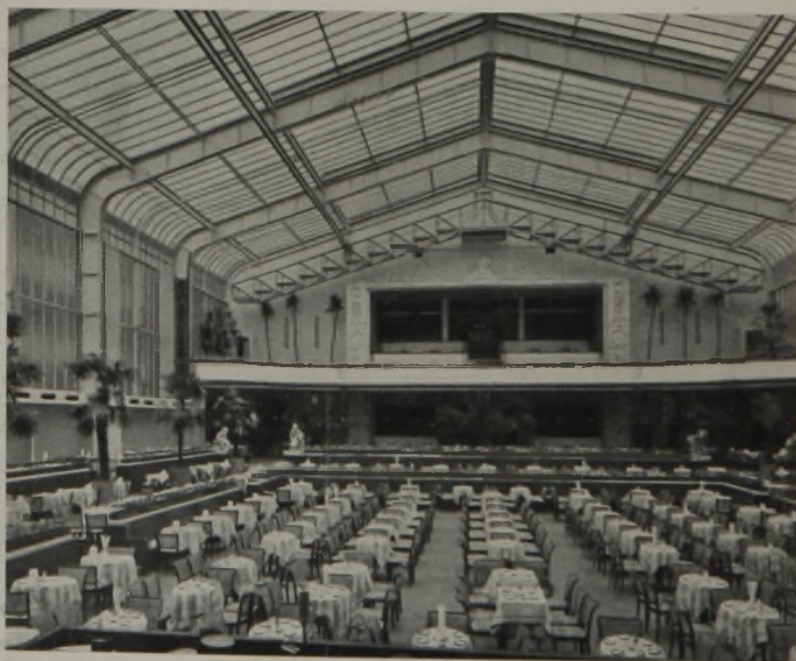
Die gute Form der Stahlkonstruktionen mit ihren sauberen Verbindungen ist unverdeckt überall sichtbar. Der helle Anstrich hat die Schwere der Binder zurücktreten lassen.
