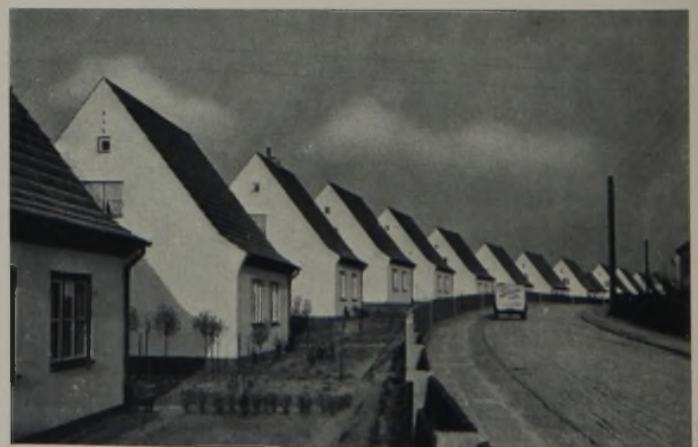
Eine der Siedlungsstraßen kurz nach der Fertigstellung.
