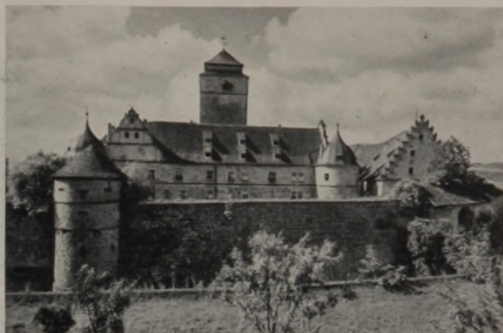
Nordflügel des Schloßhauptgebäudes. Im Vordergrund links der Rosenturm, ein Zeuge aus dem ersten Wehrbau.
