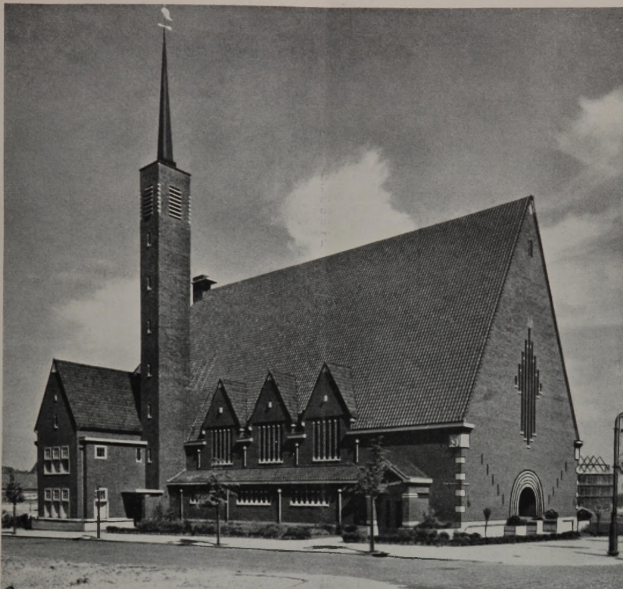
Die Lebendigkeit der Klinkerflächen, gesteigert durch die konstruktiv geschickte Verwendung des hellen Naturgesteins, die Beweglichkeit der einzelnen Glieder und die rhythmische Aufteilung der Gruppen ist leicht und lebensnahe. Die wetterzerteilende Dachform, im Inneren durch die gerundete Form der Hetzerbinder gemildert, hat auch ihre Schwächen, wenn, wie hier, die Traufen auf Kosten der Architektur vernachlässigt werden.
