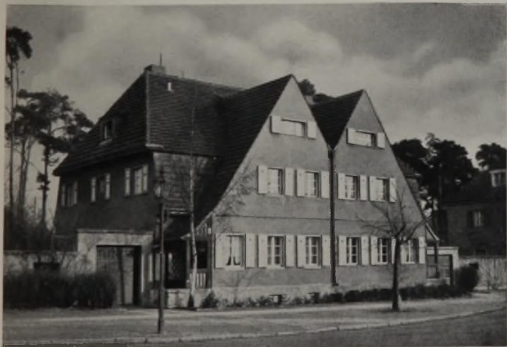
Verdoppelte Gemütlichkeit für die Fassade. Besser sollten vorher die Dachschiftung, der Schneesack, die Regenrinne, der Wasserablauf und die Seitentore wirtschaftlich bedacht werden.
