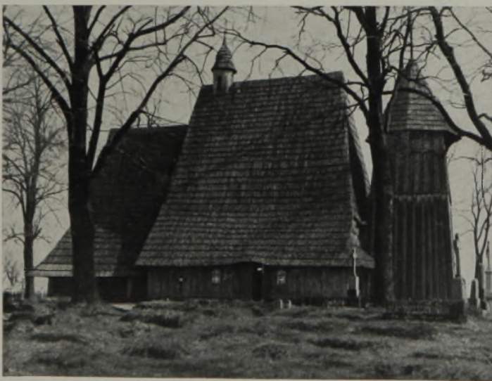
Der urtümliche Eindruck der Holzkirche zu Latscha ist durch das mächtige Schindeldach bestimmt, dem Anflugmoose eine interessante Altersfärbung verleihen. Sie weicht insofern von den übrigen Anlagen ab, als ihr die Umgänge und Vorbauten fehlen. Besonders zu beachten ist, daß das achteckige Zeltdach des Turmes ohne weiteren Uebergang auf dem viereckigen Unterbau ruht.
