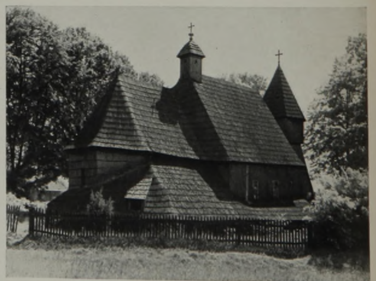
2 Aufnahmen: Hans Retzlaff, Berlin. Die Schrotholzkirche zu Boitschow ähnelt der Beuthener Anlage und stellt den Typus dar, den wir in Oberschlesien am häufigsten antreffen. Die Hallengänge unter den Fenstern umschließen den ganzen Bau, am Chor weiter ausladend. Der Turm mit überhängender Glockenstube steht organisch an der Westfront. Ein viereckiger Dachreiter krönt das Gebäude.
