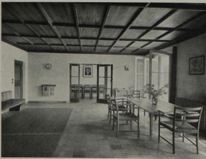
Studentenschafts-Wohnraum: Doppeltüren sichern die Wärmehaltung. Mattenbelag gegen Fußkälte für die Wintermonate. Decke in naturlasierten Sperrplatten mit profilierten Leichtruppen. Fußboden in Natursteinplatten mit gleitsicherer Raufläche. Warmwasserheizung. Appellplatz in Solnhofener Platten. Beleuchtung an den Stirnseiten schlicht, praktisch und wohnlich!
