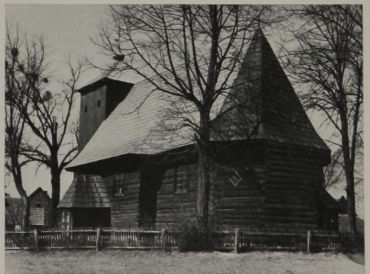
Die Kirche zu Jamm nimmt eine Sonderstellung unter den schlesischen Schrotholzbauten ein, da wir alle typischen Merkmale, wie Hallengänge, Flugdächer, Dachreiter und Wandverkleidung, vermissen. Nur ein kleiner Vorbau kennzeichnet den Eingang in gewohnter Weise.
