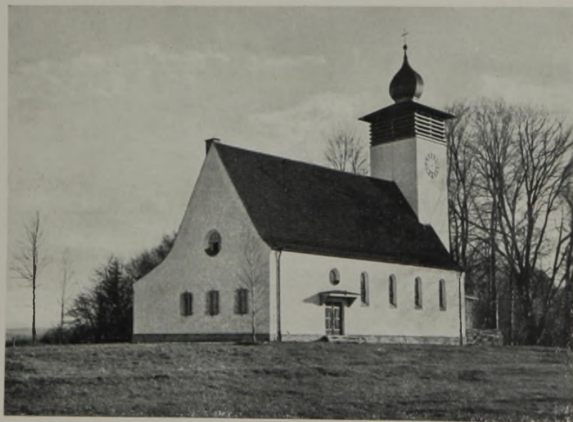
Blick von der Höhe (Nord-West) auf den rückwärtigen Baurakt der Kirche mit dem über den seitlichen Anbau (Sakristei) herabgezogenen Schleppdach.
