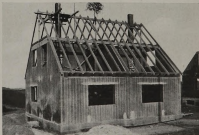
Ausgeschaltes Haus mit Dachstuhl.
