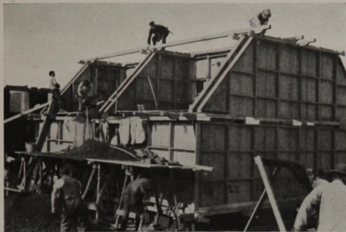
Einbringen des Schlackenbetons. Unten: Fertig geschüttetes Haus in Schalung.
