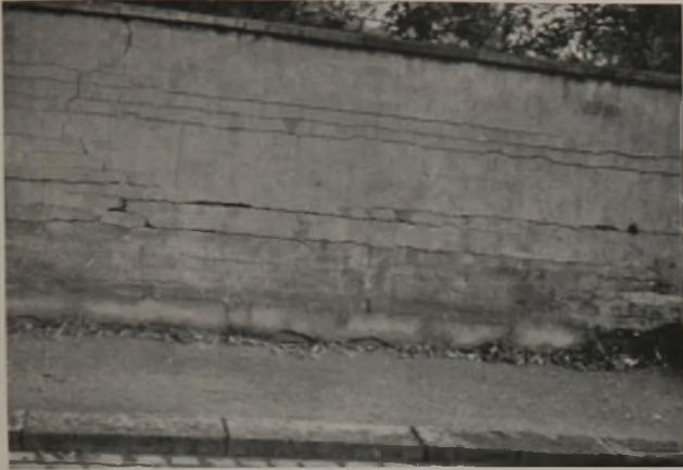
Abb. 1. Trennung der Mauer durch Rost und Risse in jeder Schicht. Aufziehen der Grund- und Spritzfeuchte infolge mangelhafter oder fehlender Sperrschicht. Fehlender Hartputzsockel. Keine Vertikal-sperrschicht. Feuchte unter der Abdeckung.
