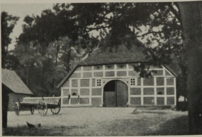
Abb. 9. Kräftiges, scharfkantiges Eichenfachwerk bei einem Heidehof, das, durch innere starke Binder gestützt und verbunden, der äußeren Verstrebung (Bügen) nicht bedarf. Die nach den Ecken engere Einteilung der Gefache hat sich aus dem statischen Gefühl stärkerer Belastung der Traufkanten und der Eckknotenpunkte ergeben.
