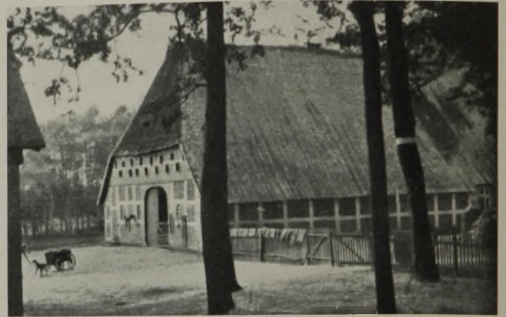
Abb. 10. Die schützende Wirkung des großflächigen Steildaches in weicher Deckung und der konstruktive Aufbau beweist Heimatempfinden und Sicherheit der alten Handwerker in der landschaftsgebundenen Bauweise.
