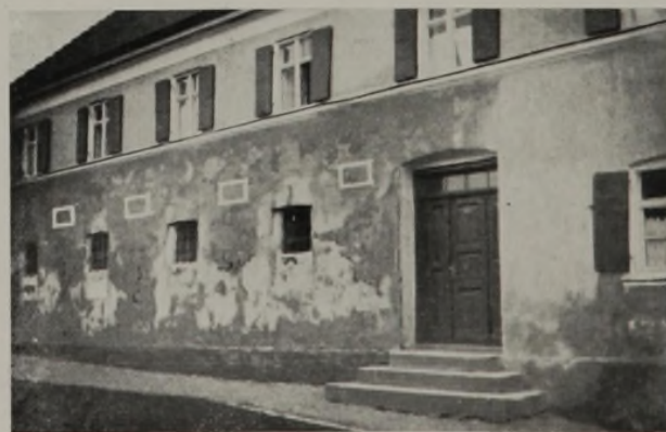
Abb. 3. Doppelte Wandschädigung durch mangelhafte Isolierung und Raumschweißwasserbildung. Folge: Großer Fettverlust des Viehes.
