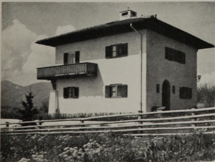
Blick auf Nord- und Ostseite des Hauses.
