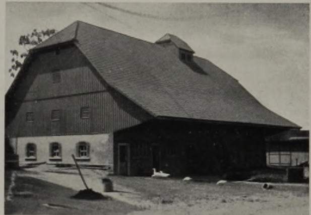
Abb. 12. Die kalten (38 cm starken) Mauern dieses modernen Stallgebäudes wurden nachträglich innen-seitig mit Leichtbauplatten zusätzlich isoliert, weil Schwitzwasser auftrat.
