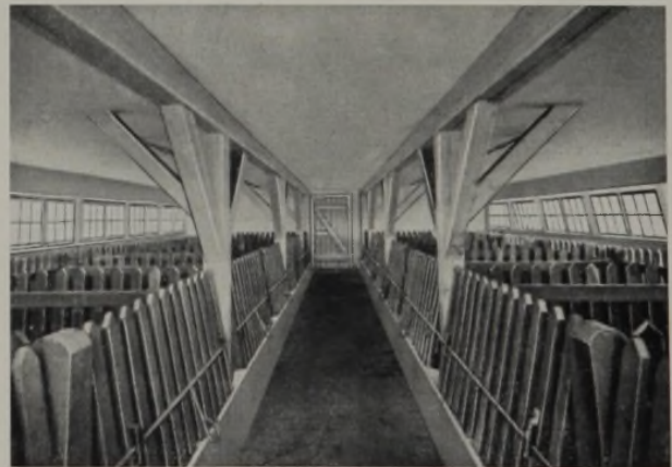
Abb. 13. Ein Musterstall (Staatl. Domäne Altenklosterhof im Westerwald. — Schweinezuchtstall). Holzskelett mit Leichtbauplatten verkleidet. Der Stall ist warm, feuersicher, sonnig und vollkommen trocken.
