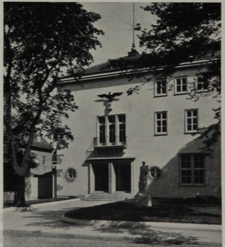
Arch.: Georg Schirrmeister, Gera.
