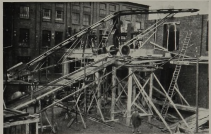
Abb. 4. Das Förderband ist für den Transport des Betons für die Erdgeschoßdecke aufgebaut und wird von einem kräftigen Gerüstbock unterstützt. Bei dem Gewirr von Gerüstverstrebungen ist die aufgeräumte Arbeitsstelle Bedingung.
