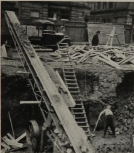
Abb. 1. Beförderung von Boden und Schutt der Baugrube unmittelbar in den Lastwagen; Ersparnis an Arbeitskräften. Nicht aufgeräumte Baustelle oberhalb der Baugrube führt leicht zu Unglücksfällen.
