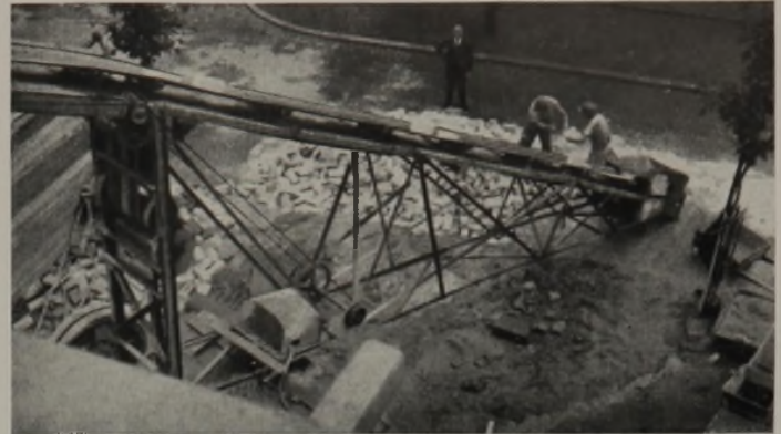
Abb. 3. Transport von Mauersteinen — Kalksandsteinen — von der Straße in die unteren Geschosse des Neubaus.
