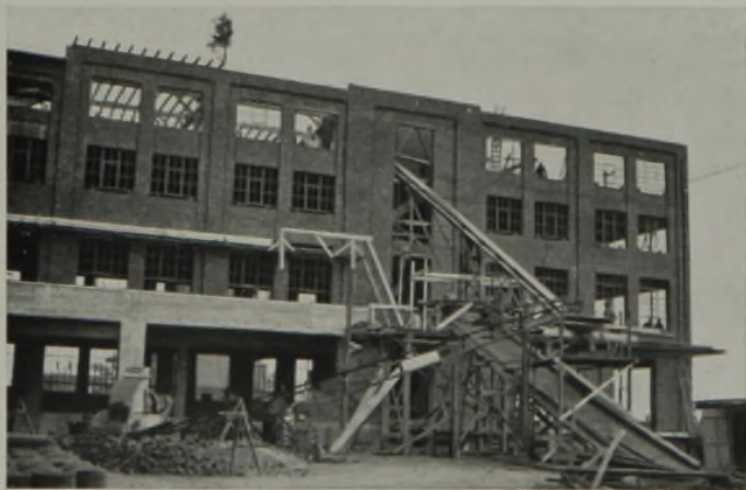
Abb. 5. Aufbau von zwei Förderbändern im rechten Winkel zur Förderung der Baustoffe in das II. und III. Obergeschoß. Auch hier zeigt die Lagerung der Baustoffe in nächster Nähe des Mörtel- und Betonmischers und Förderbandes und die aufgeräumte Umgebung den erfahrenen Bauleiter.
