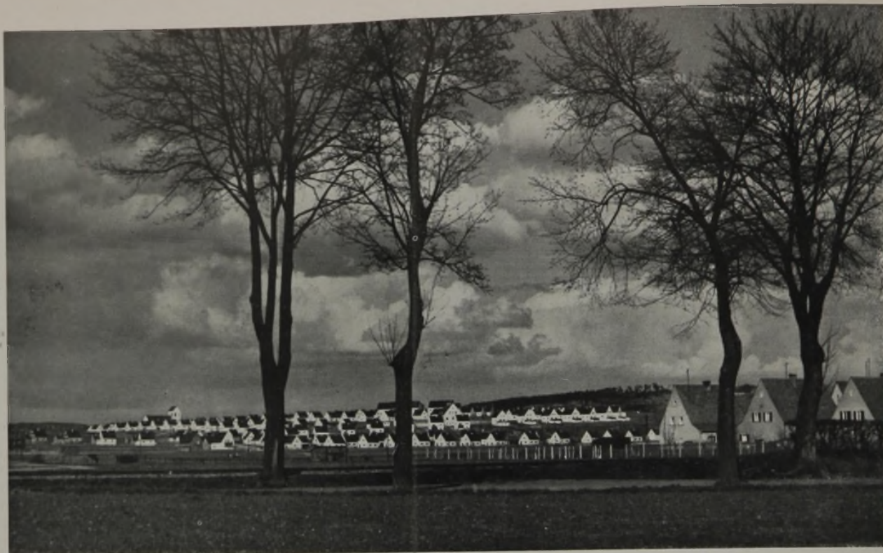
Siedlung Schottenheim, Teil Flachelberg von Süden.
