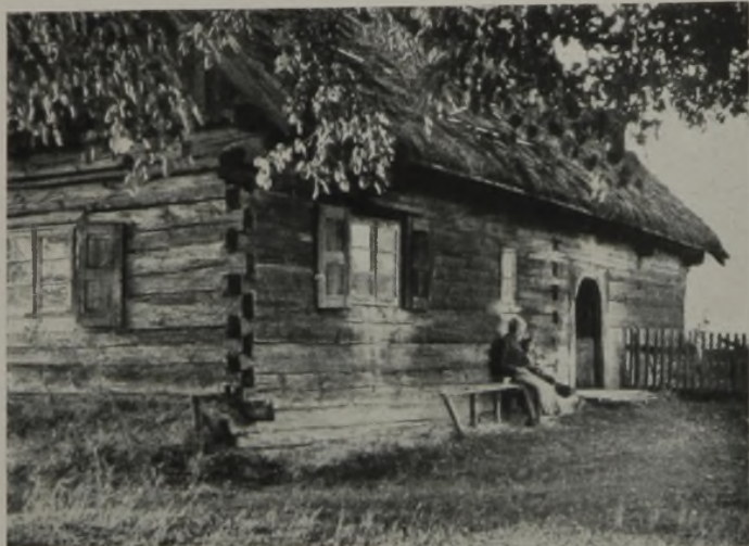
Urtümliches masurisches Bauernhaus in reiner Blockbauweise, die von dem früheren Holzreichtum zeugt. Die Balken sind waagrecht verlegt und an den Ecken werkgerecht verzinkt. Die Zwischenwände sind in die Längswände eingezapft, wodurch der Grundriß im Außen sichtbar wird.
