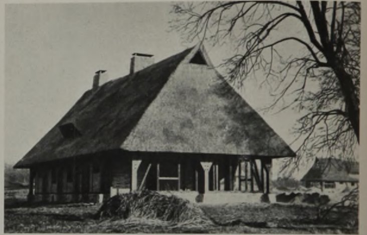
Neues Haus aus der entstehenden Waldarbeiter-Siedlung in Schlesien in ostgermanischem Stil. 10 Waldarbeiterhäuser sollen in Neuworwerk zu einem Runddorf vereinigt werden. Sockel aus Findlingen. Dachdeckung: feuerfest imprägniertes Schilfrohr.
