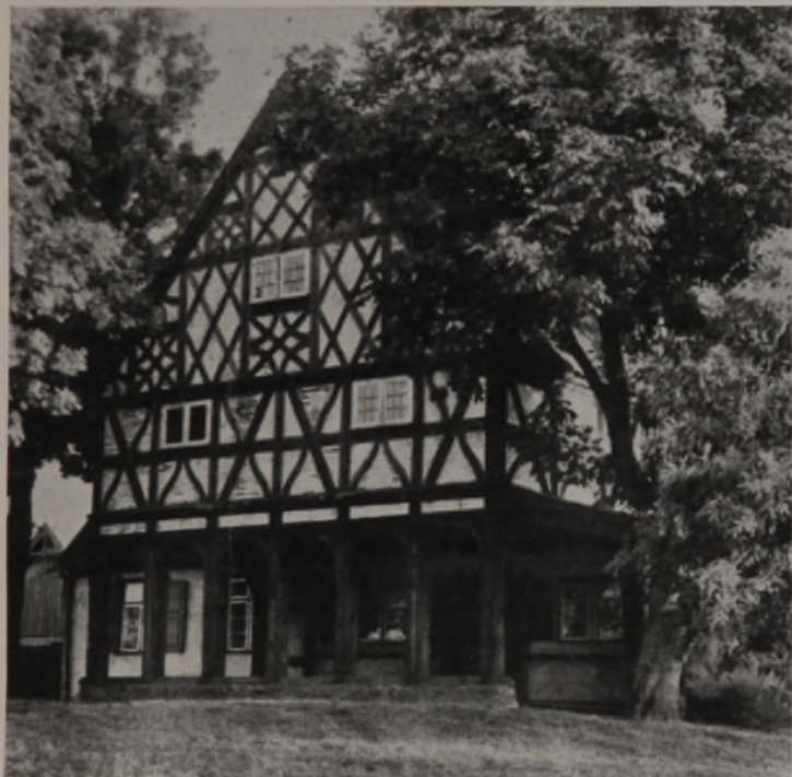
Vorlaubenhaus in Gottswalde, Danziger Niederung. Das Obergeschoß ist weit über den Unterbau vorgezogen und durch Säulen abgestützt, die auf einem durchgehenden Steinsockel ruhen. Die Fachwerksfiguren, die mit den burgundischen Stabbildungen übereinstimmen, lassen auf eine alte Ueberlieferung dieser Bauweise schließen.
