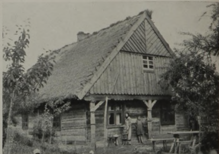
Dies charakteristische Beispiel eines ostpreußischen Giebelständerhauses zeigt, daß die bodenständige Form genügend Spielraum gelassen hat, um den Typ immer wieder abzuwandeln. Vor allem die Giebelausbildung und Säulen lassen erkennen, in welchem Umfang auch einzelne Bauteile die Phantasie des Zimmermanns angeregt haben.
