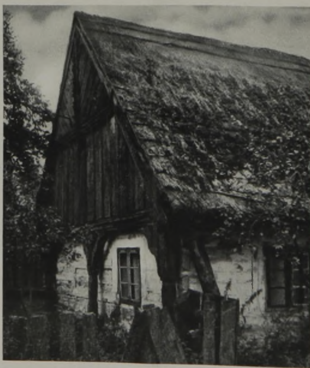
Auf der Giebelseite ist die Dachlast auf ein Ständerwerk übertragen, das vor die weißgekalkte Blockwand gerückt ist, um diese zu entlasten. Die sorgfältig behauenen Balken und der Eckverband zeugen von der Vervollkommnung der Zimmermannskunst. Im Vordergrund ein leider dem Verfall anheimgegebener Bohlenzaun.
