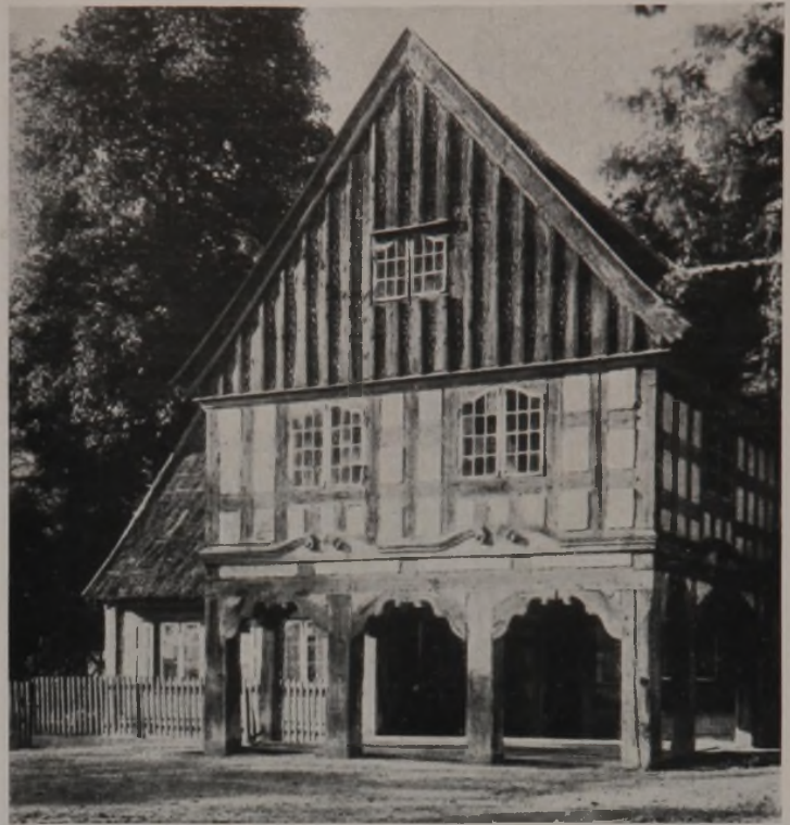
Barockes Vorlaubenhaus in der Danziger Niederung in einer für ein Bauernhaus erstaunlichen Formvollendung. Das Ständerwerk bietet einen Ueberschuß an Masse dar, die über die statisch erforderliche Tragfähigkeit weit hinausgeht. Die Wirkung des Hauses wird hierdurch aufs schönste gesteigert.
