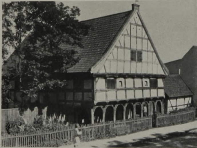
Einfaches Vorlaubenhaus in der Danziger Niederung. Die Stützen sind durch geschweifte Kopfbänder miteinander verbunden, eine Bauweise, die schon um die Mitte des 5. Jahrhunderts von dem oströmischen Gesandten Priscus als ostgermanisches Baugut erwähnt wird.
