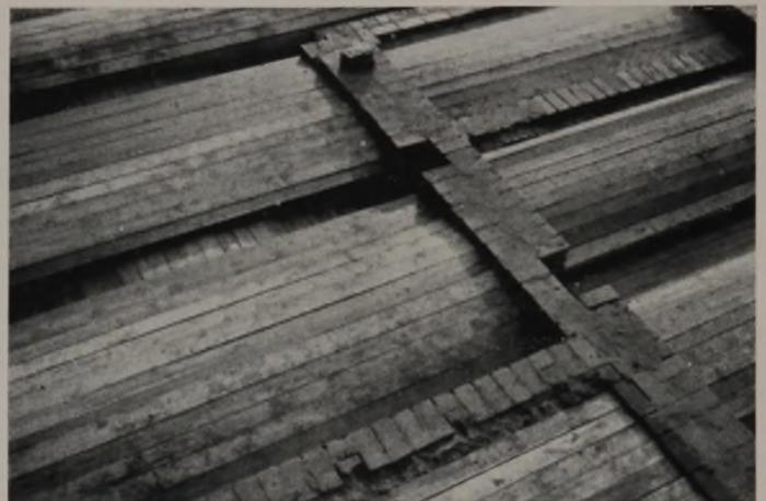
Abb. 3. Fortschritt in der Gewölbeausführung. Gurtbögen, Kappen und Zwickel werden in einem Arbeitsgang in Kiesbeton eingestampft, die Zwickel in Magerbeton. Das bedeutet die Ersparung an Material und Verkürzung der Bauzeit. Die Abbildung zeigt die Gurtbögen und Kappeneinschalung, gesäubert vor der Einstampfung.
