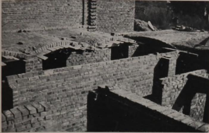
Abb. 1. Bei diesem Doppelhaus waren noch waagerechte Kappen zwischen I-Trägern vorgesehen. Diese wurden für den ersten Bau geliefert, beim 2. Haus trat eine Verzögerung ein. Um nicht zum Stillstand zu kommen, entschloß sich der Bauleiter zu Preußischen Kappen auf Zwischenwänden, die Spannweiten bis zu 1,80 m, der Stich ein Achtel bis ein Zehntel der Spannweite, also rund 0,20 m.
