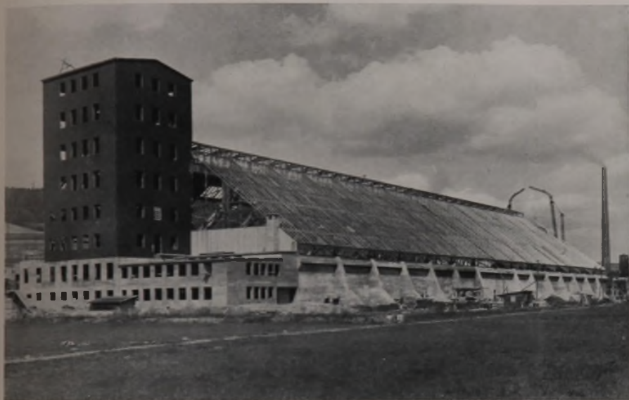
Abb. 1. Der gleichmäßig hohe, zusammenhängende, zweigeschossige Betonkörper bildet das sichere Fundament für die große Belastung. Die starken Strebe Pfeiler zeigen deutlich die Aufnahme der Binderspannungen, den Kräfteverlauf und die Uebertragung auf den Baugrund. Durchgehende Laterne zur Raumlüftung und Belichtung des oberen Förderbandes. Die Holzkonstruktion des Turmes ist außen mit Platten verkleidet.
