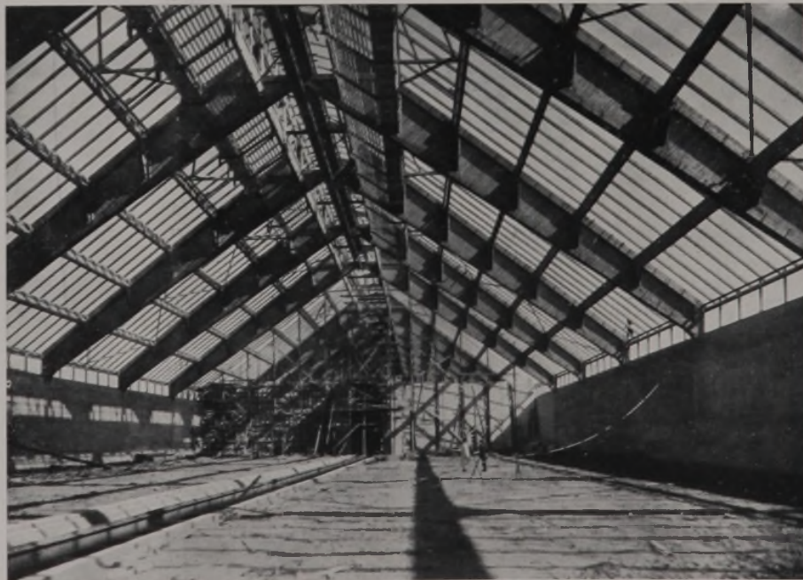
Abb. 2. Freitragende, genagelte und verbolzte Vollwandbinder, die im Querschnitt ähnlich den I-Trägern ausgebildet sind. Zwischenpfetten in gleicher Konstruktion mit kopfbandartiger Ausbildung der Auflager. Durchgehende, stark belichtete Laterne mit Förderband und Laufbühnen. Die Sparren wirken bei den gewaltigen Dimensionen der Halle wie Streichhölzer. An der Laterne ist in den oberen Feldern mit Lattung für die Bedachung begonnen.
