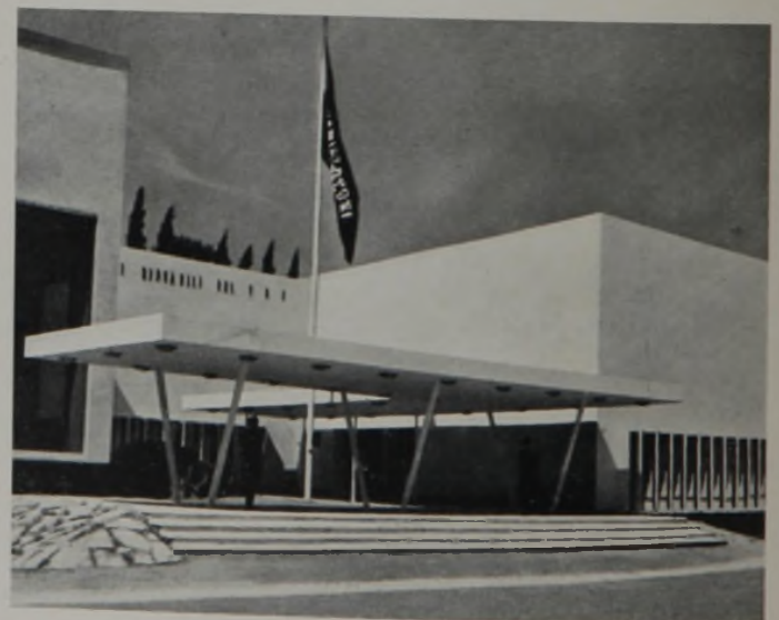
Ausstellungs-Eingang. Arch.: Franco Petrucci. Das durchaus geglückte Erstaunen der Besucher einer schwebenden Portaldecke auf Wackelstelzen. Unsichtbar bleibt die kostspielige Errichtung, was den Haupteffekt macht.
