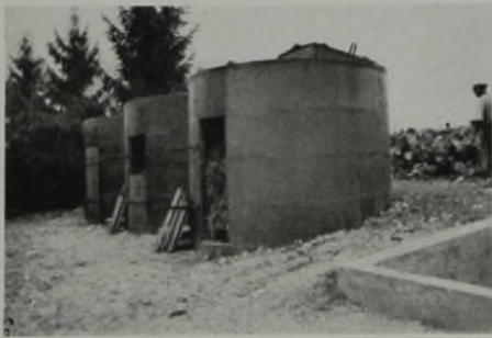
Dreiteiliger Humusbereiter, bestehend aus drei Rundbehältern von je 15 cbm Fassungsraum, für eine Heil- und Pflegeanstalt (Schloß Stetten i. R., Württemberg) aus Rundformstein, Einfüllseite.
